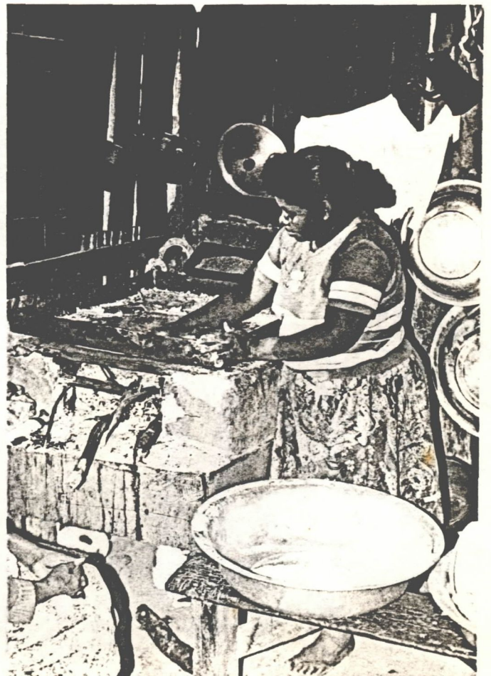
Foto 19 – A conjugação do fogão à lenha com uma grande forma de lata compõe o forno empregado na fase final da fabricação da farinha de casquinha.
