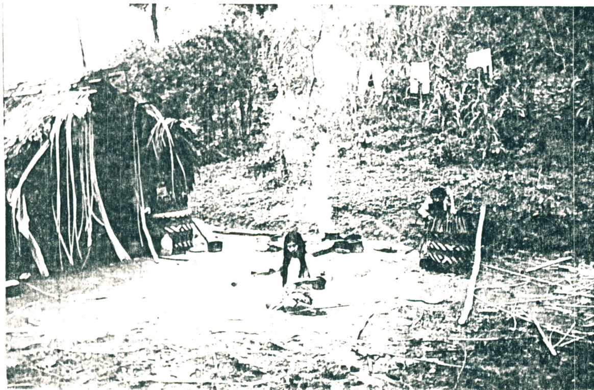
FOTO Nº 11 - Habitação de Bracuf - Aldeia Sapucaia
